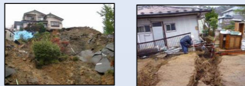
滑動崩落の事例
